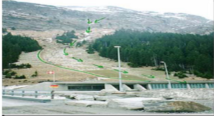
Fotoğraf 12: Saptırma Duvarı ve Çığ Tüneli
