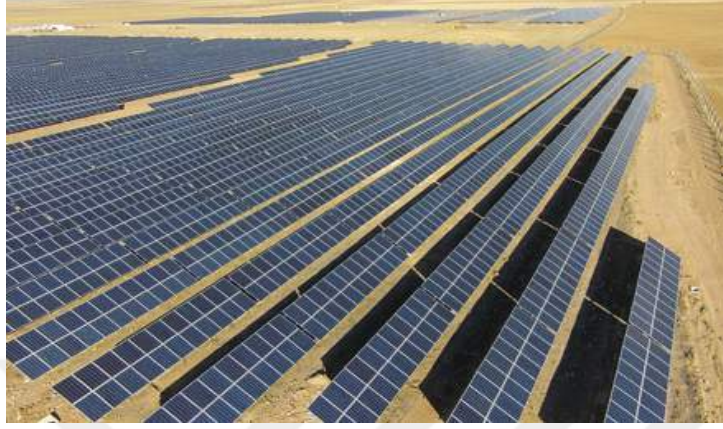
Şekil 2. Türkiye'nin en büyük güneş enerji santrali, Konya Kızılören ( https://www.teknoraysolar.com.tr )
